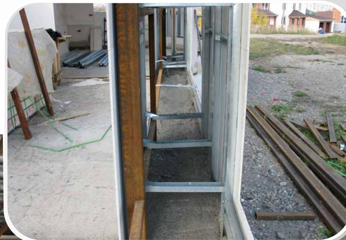
Устройство наружной стены здания
