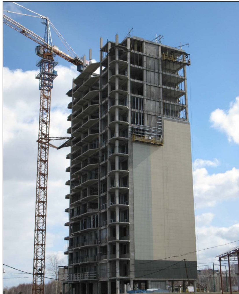
Строительство 16-этажного жилого дома в г.Томске
