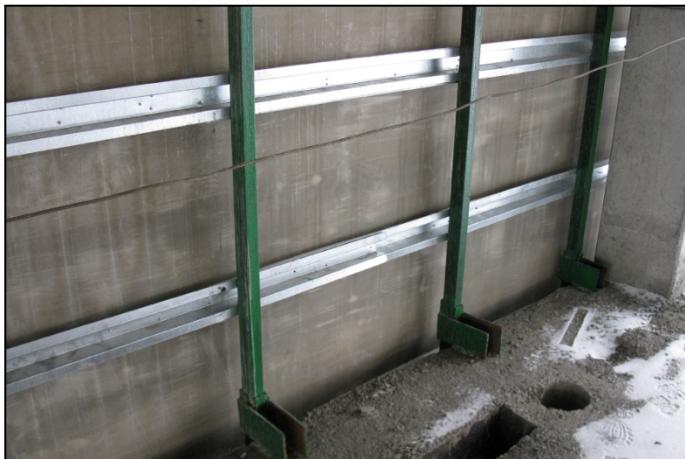
Узел крепления керамогранита
